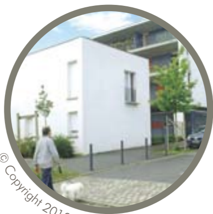
Un traitement particulier des espaces publics Servon-sur-Vilaine (35) – Les Vignes Architectes : Atelier JAM Densité : 110 log./ha
